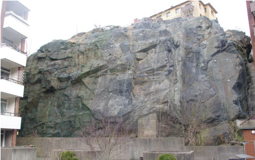
Figur 9. Skärningen mellan och bakom fastigheter 2:42 och 2:43 säkrad med bergbult och bergnät.
